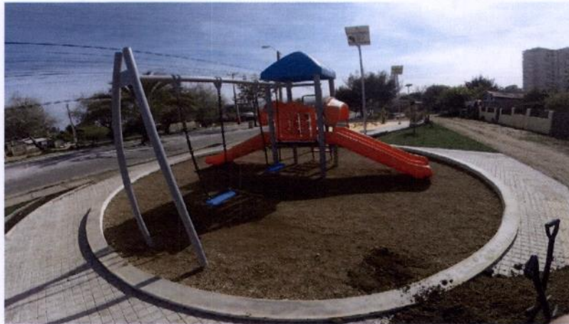
CONSTRUCCIÓN PLAZA AGUAS MARINAS
