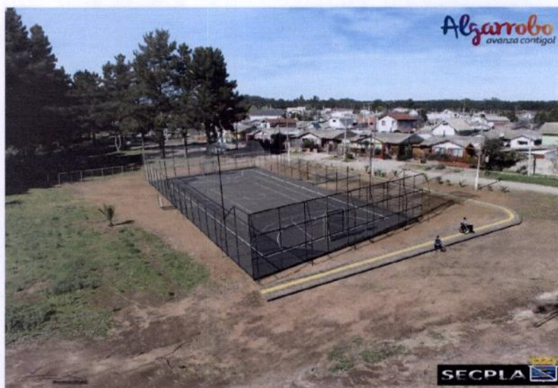
CONSTRUCCIÓN MULTICANCHA PARQUE RESIDENCIAL
