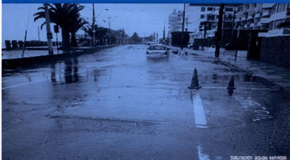
Saturación aguas servidas
