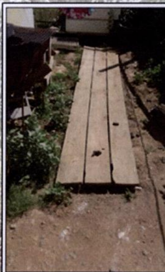
DREN COLAPSADO SIN ESCALA
