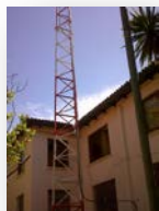
FOTO N° 10: Reposición antena Radiocomunicaciones Municipalidad de Algarrobo.
