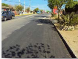
FOTO N° 12: Pavimentación Bermas Sur. Avenida Guillermo Mücke.
