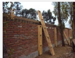
FOTO N° 11: Reconstrucción cierre perimetral. Estadio Municipal de Algarrobo.
